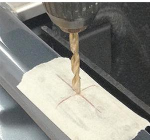
11. Percez un trou pilote de 3mm à 15mm du bord intérieur de chaque marque. Percez à nouveau avec une mèche de 9mm.
